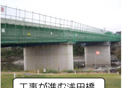
工事が進む浅田橋
