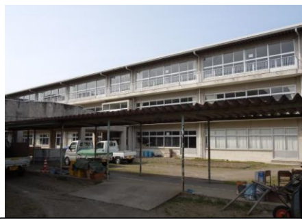
渋川北小学校中校舎耐震改修
