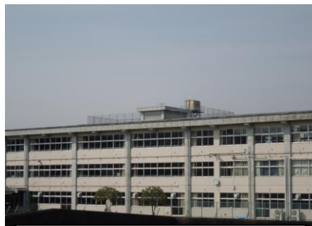
渋川中学校南校舎耐震改修
