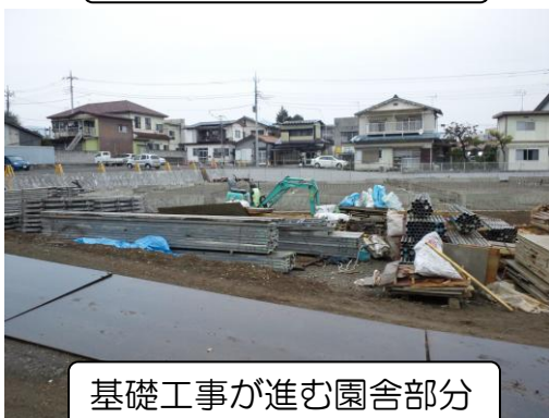
工事が進む渋川幼稚園
