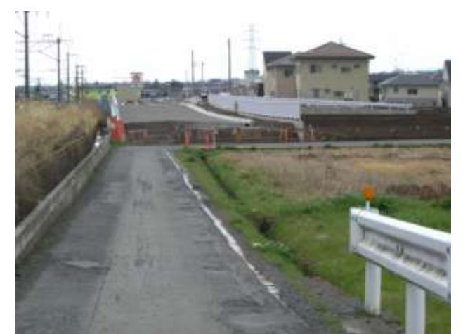
工事が進む（仮称）辰巳町有馬線
